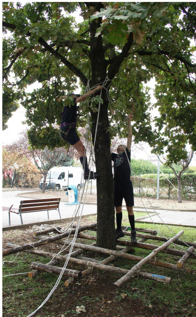
**5. LE CORDE.** Completata la struttura è il momento del fissaggio delle corde al tronco. È possibile fissare la corda fulcro della giostra sia su tronco liscio che all'altezza dei primi rami dal suolo. Utilizzare 5 corde separate (4 per la giostra e 1 per realizzare una legatura a fascia sul tronco). Noi avendo a disposizione un'unica corda abbiamo utilizzato il metodo che andiamo ad illustrare:
